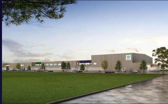
Si Sa Ket Swine Slaughtering Plant
